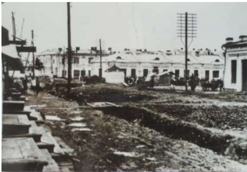
Траншея под водопровод вдоль улицы Ленина. 1928-29 гг. Фото предоставлено А.А. Щиголем
