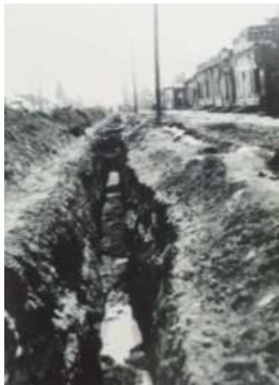
Траншея под водопровод вдоль улицы Ленина. 1928-29 гг.
