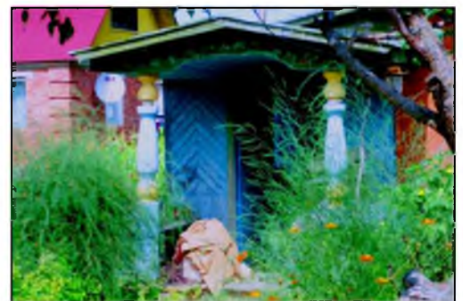
Рис. 25. Резьба опорных столбов крыльца (с. Дубовый Ключ, ул. Садовая)
